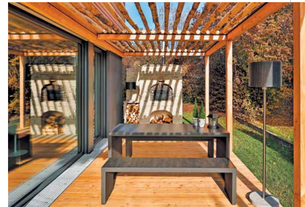
Die Dachuntersicht wurde mit Fichte-Mehrschichtplatten beplankt, anthrazitfarbene Putzflächen und Tectura-Platten sowie eine unregelmäßig breite Lärchenholz-Verschalung geben dem Holzhaus eine moderne Optik.
